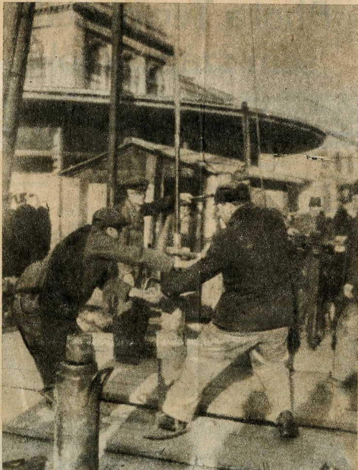
Próbafúrások az új földalatti vonal egyik helyén
