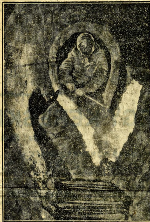
Az évekig tartó földalatti kőborlások során a bűvárok megtalálták a Podmaniczky ucca alatt ezt a nagy csatornaomlást, amely az egész környéken zavarta a szennyvíz lefolyását.
