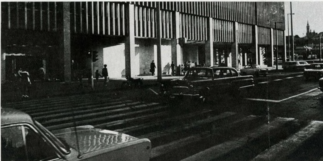
A Metró bejárata a Kossuth Lajos téri irodaház földszintjére
