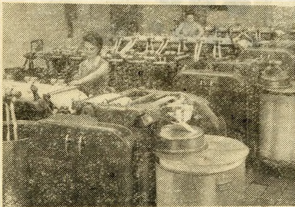
A Magyar Posztógyár egyik új gépe: a kábelvágógép, amely fonásra készíti elő a szintetikus szálát
