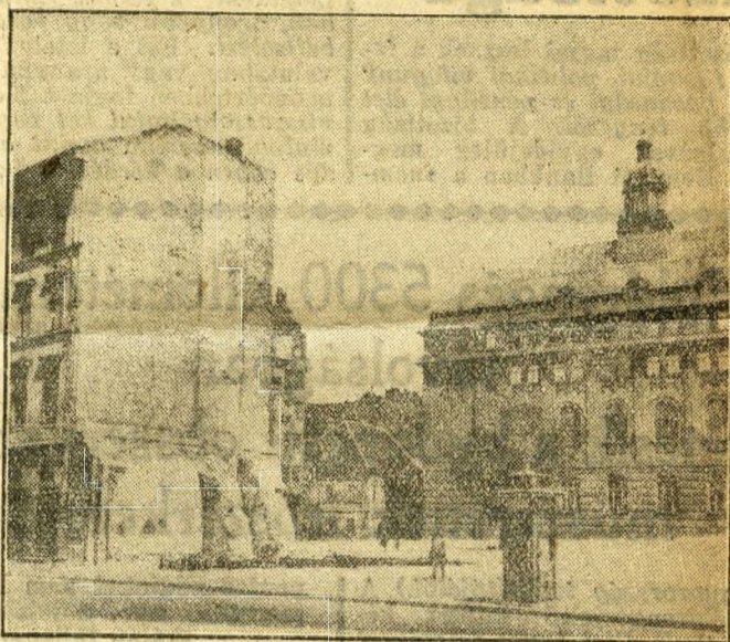
A lebontott piarista épület helye, a még lebontásra váró épületrésszel
