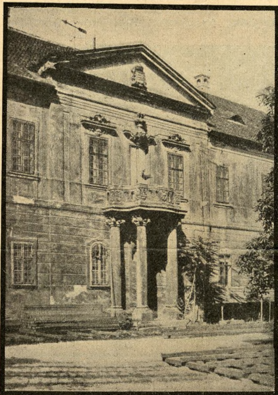
A gróf Zichy-család kastélya Óbudán. A Mária Terézia-korabeli barokk-stílusú, oszlopos erkélyű épület a barokk legszebb emléke a fővárosban. Különösen szép a lépcsőháza. Ma raktár és szármalmasan elhanyagolt állapotban van a körülötte levő idomtalan kaszárnyák között.
