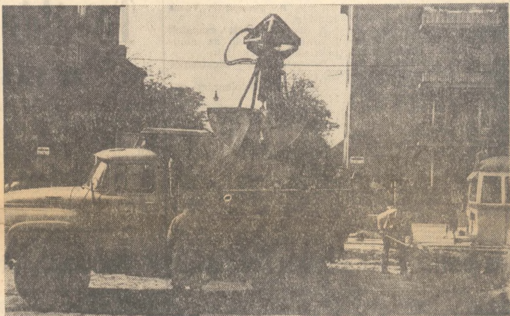
A markoló rakodás közben
