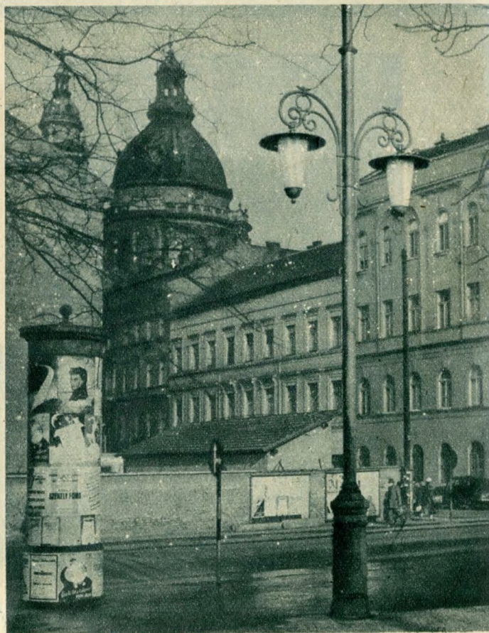
Az Engels téri kandeláberekre szerelt kétkarú fénycsöves lámpa
