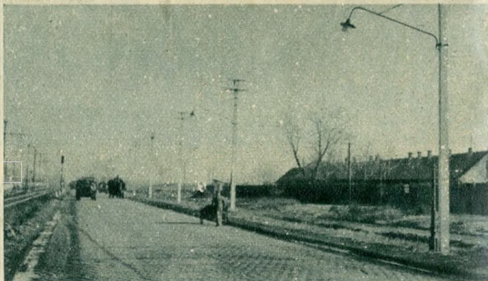
Az úttest fölé nyúló karra szerelt izzólámpa rendszer a Kerepesi úton
