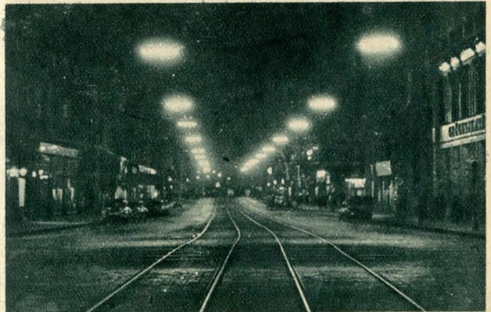
Fénycsőves útközepes lámpa — átfeszítésenként két lámpatesttel. Éjjel a Kossuth Lajos utca
