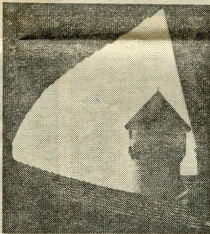
A várpalota rekonstrukciója során helyreállított buzogánytorony.
