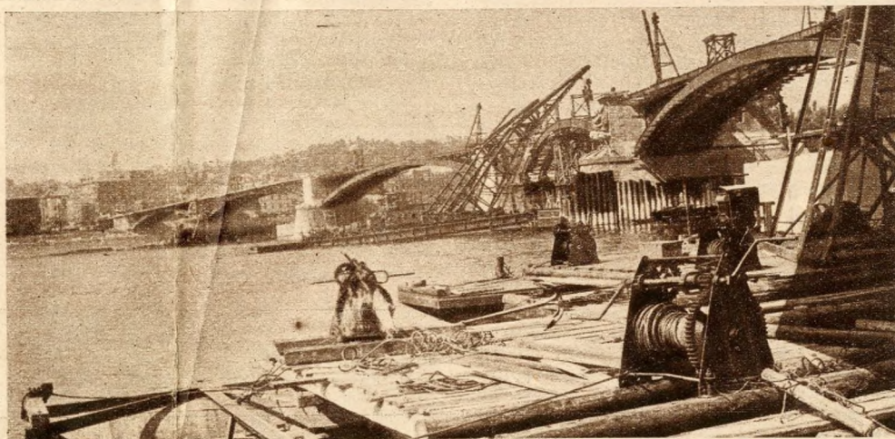
ÉPÍTIK A MARGITHIDAT, az elsőt, amit szép hidjaink közül a náciak felrobbantottak. Két részben épült fél-fél szélességben. Az első felét 1947 novemberében adták át a forgalomnak
