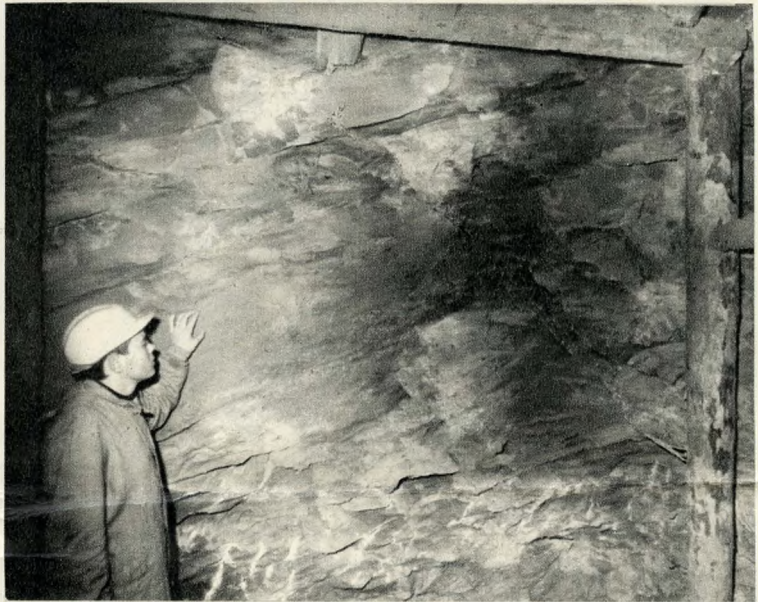
Vetődés a budai márgában a metró Déli pályaudvari szakaszán. Dr. Wein György felvétele
