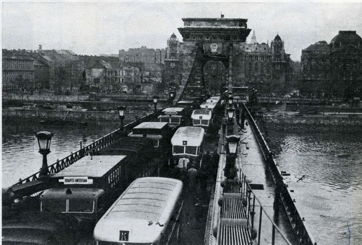
A próbaterhelés (1949. nov. 13.)
