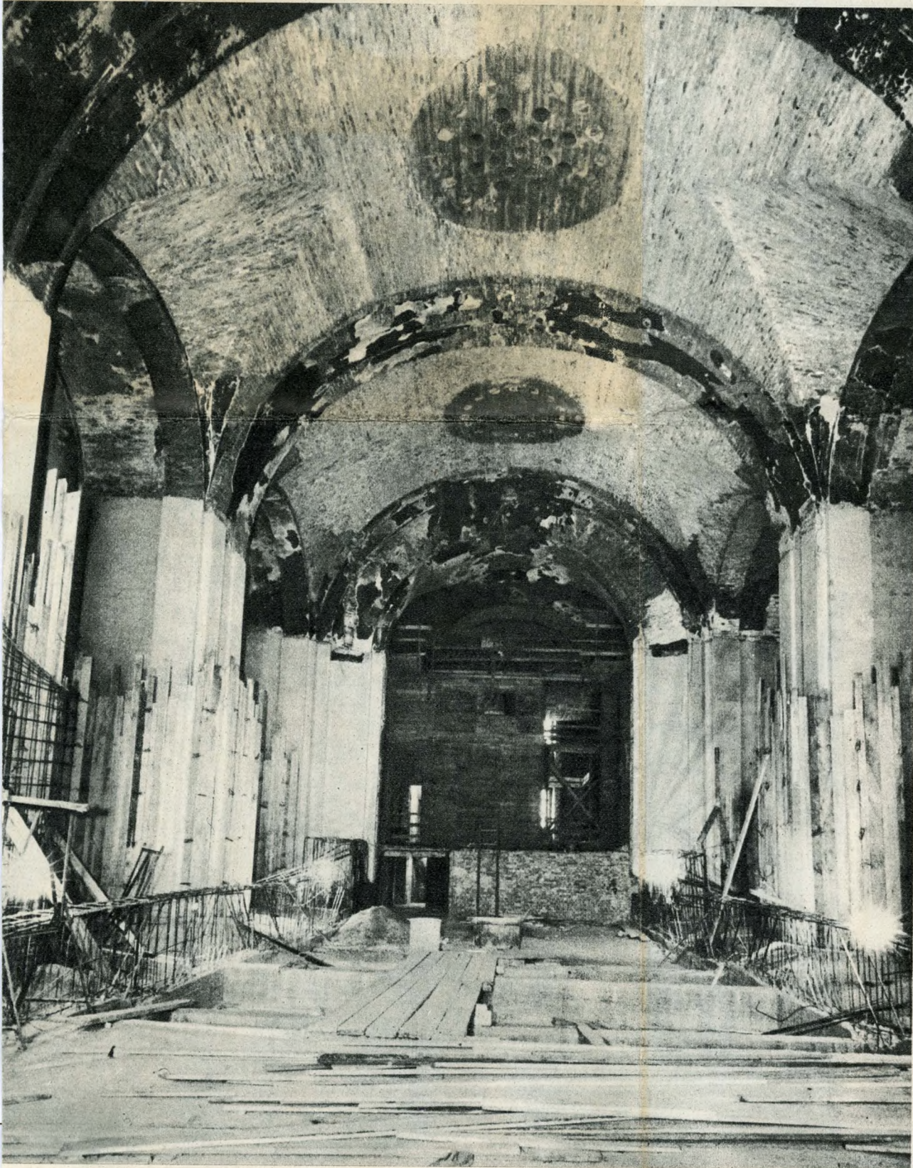
Belső tér helyreállítása
