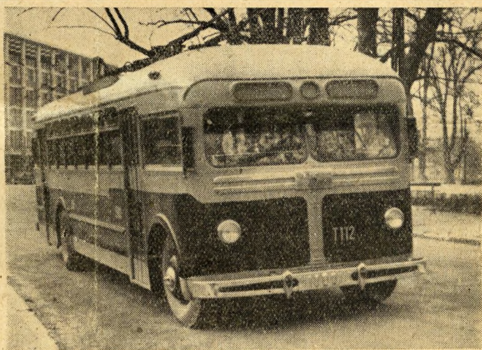
A szovjetgyártmányú trolleybusz korszerűen kiképzett homlok-része. A fényszórók között jól láthatók a szellőzőnyílások fedőlemezei. A szélvédőablak mögötti fehér vonal: a modern villamos ablakmelegítő.
