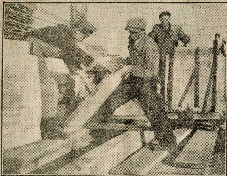
Vas Ferenc elvtárs sztáhanovista kőműves és Vadas István elvtárs segédmunkás Rimaszék Béla mérnök, helyszíni művezető irányítása mellett helyezik el az ülőelemet a Népstadion nagylelátóján.
