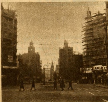
Nemrégben még állványerdő borította a Felszabadulás tér épületeit
