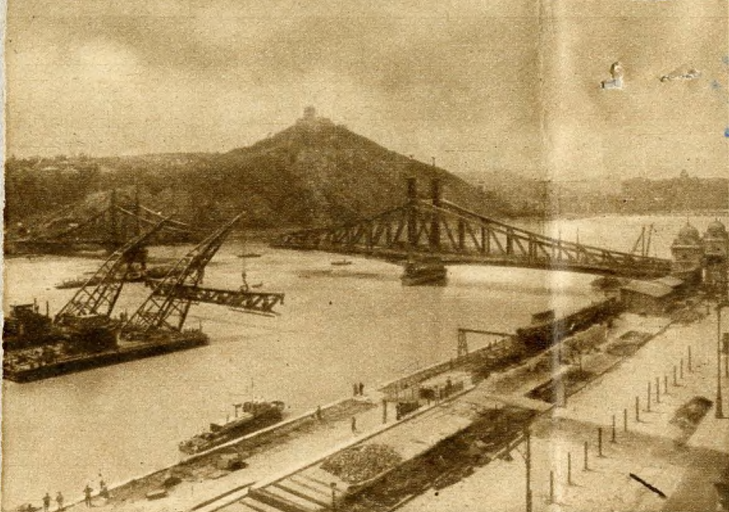
A régi Fővám téri-, ma Szabadság-híd középső részének beemelése
