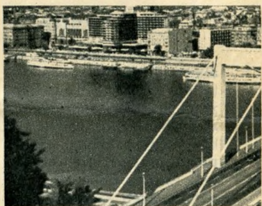
Középen: az új Erzsébet-híd: függőhid 1964-ben készült (MTI Fotó) Középen jobbra: a Margit-híd: gerendahíd (MTI Fotó) Lent: a híres „kilencikű” boltozott híd, amely a Hortobágy folyón vezet át, 1833-ban készült (MTI Fotó)
