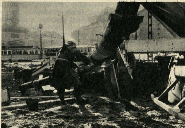
A vasbetonszerkezet készítése a helyszínen
