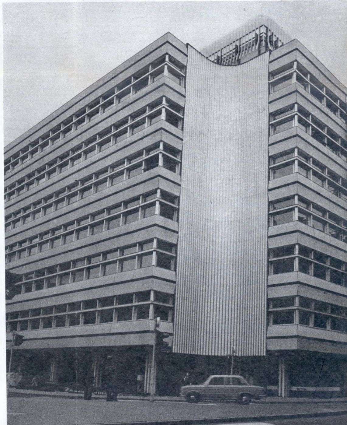
A Forgalmirányító Központ épülete
