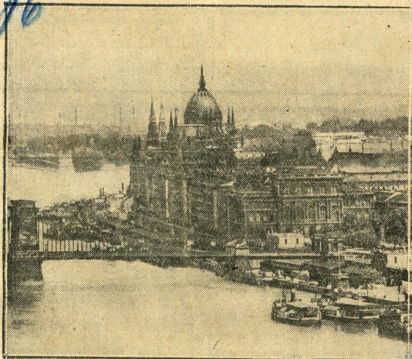
Bulwar arc. Rudolfa nad Dunajem w Budapeszcie.
