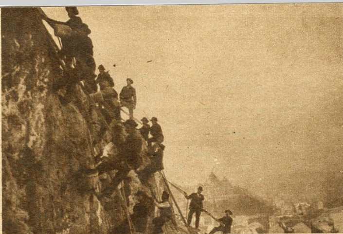
A keleti hegyoldal szikláinak megerősítése 1902-ben
