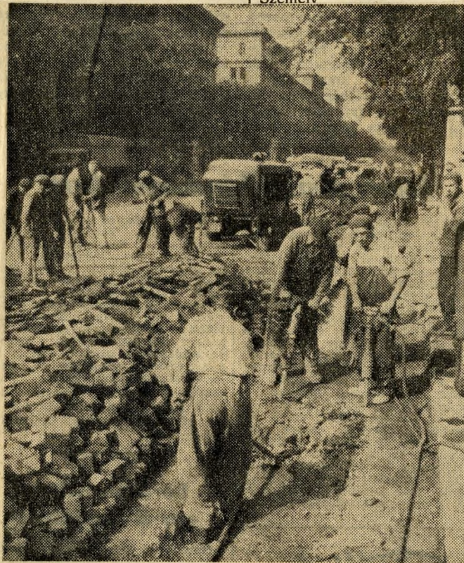
A Népköztársaság útjának korszerűsítése gyors ütemben halad: a közművek korszerűsítésével egy időben felszedik a régi faburkolatot az úttestről, s beton- és aszfaltburkolattal cserélik fel.
