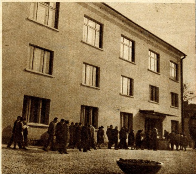
Az új épületszárny homlokzata
