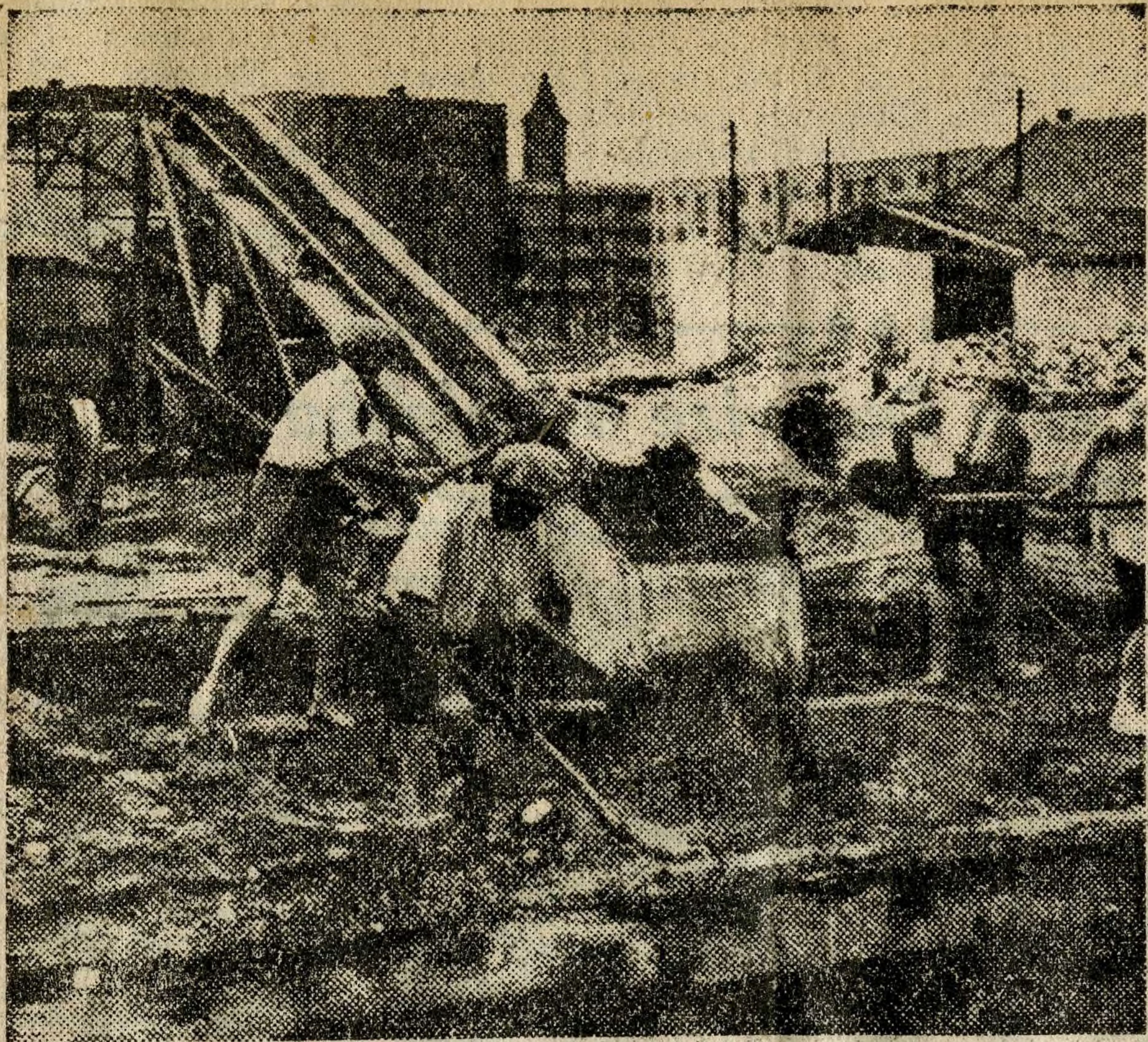
Onti a földet a szállítoszalag a csepeli munkásszálló építkezésén.
