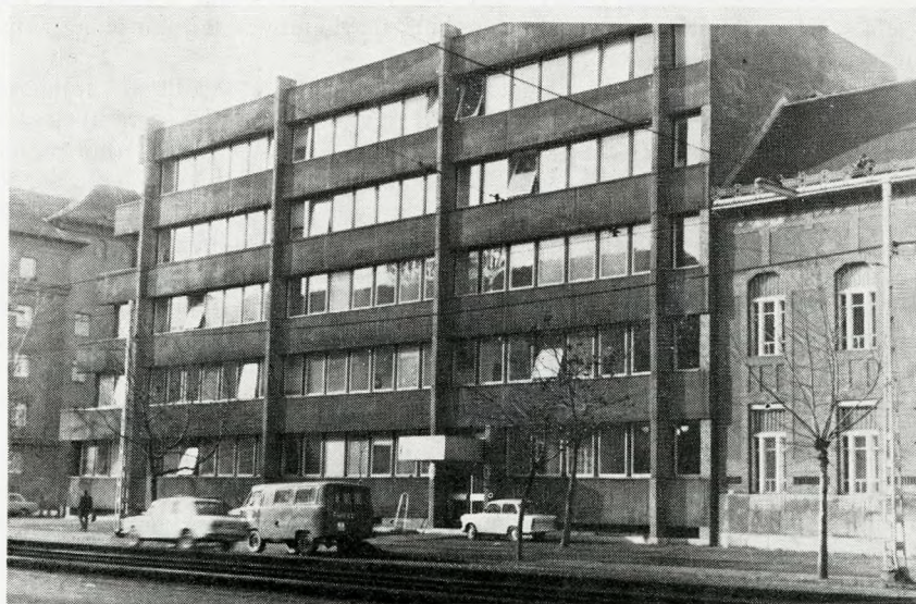
3. ábra. A Főv. KÖJÁL laboratóriumi épülete a XIII., Váci úton
