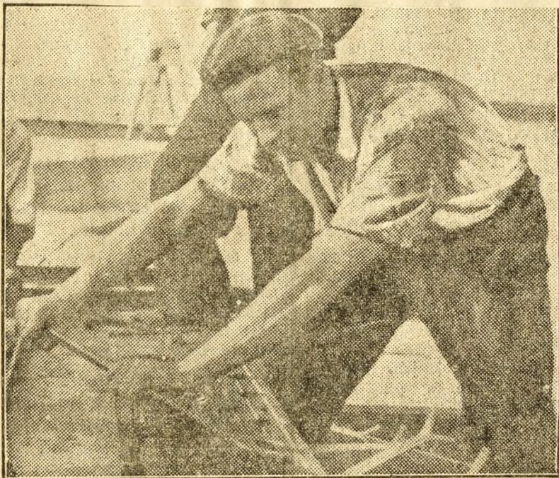
A hídépítő munka egyik legfontosabb része a vasalkatrészek szerelése. Barta Árpád hatalmas csavarkulccsal erősíti meg az alkatrészeket az épülő Sztálin-hídon.
