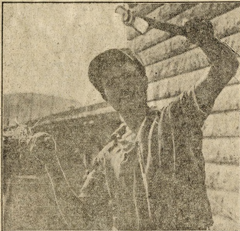
Rác Mihály kőműves mosolyogva dolgozik. Spricceli a falat a szigeti aluljáró épületén, ott, ahol a szerpentinen a babakocsik, kerékpárosok jönnek majd a hídról a szigetre.
