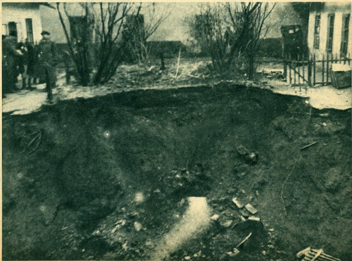
A mult évi várhegyi földcsuszamlás közelében újabb hasonló szerencsétlenség történt: a Logody-utca 16. számú ház egyik támasztófala beomlott; felső kép: a két régi kis ház magas udvarát tartotta a most beomlott támasztófal; alsó kép: kerítéssel zárták el a további földomlással veszélyeztető udvarrészt.
