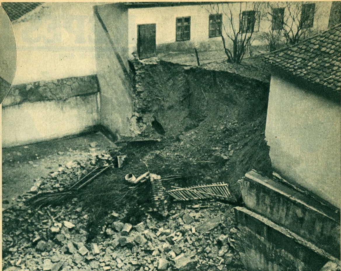
A mult évi várhegyi földcsuszamlás közelében újabb hasonló szerencsétlenség történt: a Logody-utca 16. számú ház egyik támasztófala beomlott; felső kép: a két régi kis ház magas udvarát tartotta a most beomlott támasztófal; alsó kép: kerítéssel zárták el a további földomlással veszélyeztető udvarrészt.
