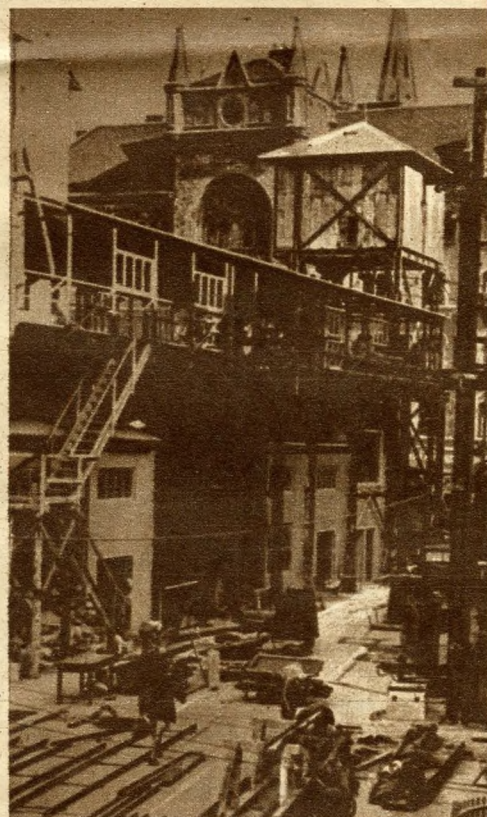
A FÖLD ALATT: a pajzskamrába már behelyezték a fúrópajzs soktonnás acélszerkezetét
