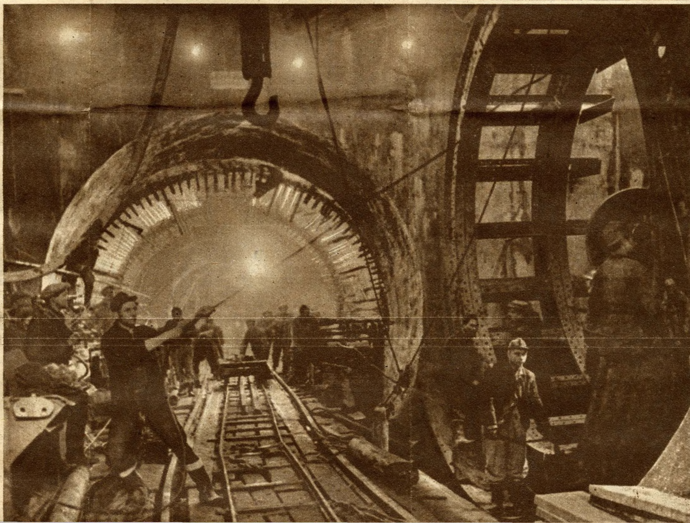
A FÖLD ALATT: a pajzskamrába már behelyezték a fúrópajzs soktonnás acélszerkezetét
