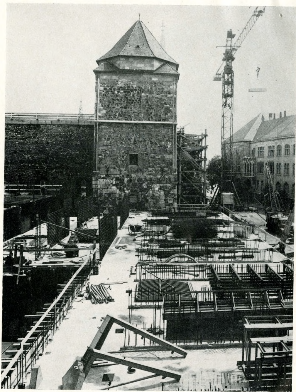
17. A szálló északi szárnyainak építése. (A torony mellett látszik a barokk homlokzat ideiglenes támasztó állványa)
