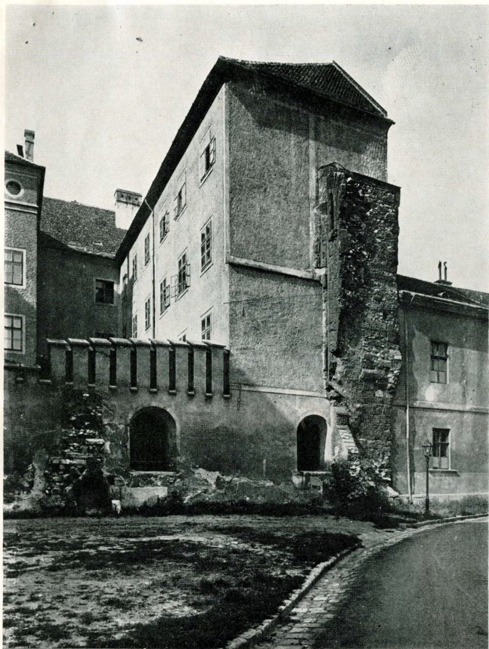
4. A templomhajó késő barokk és újabb korú beépítése. Jobbra a diadalívnek szentély felőli oldala látszódik
