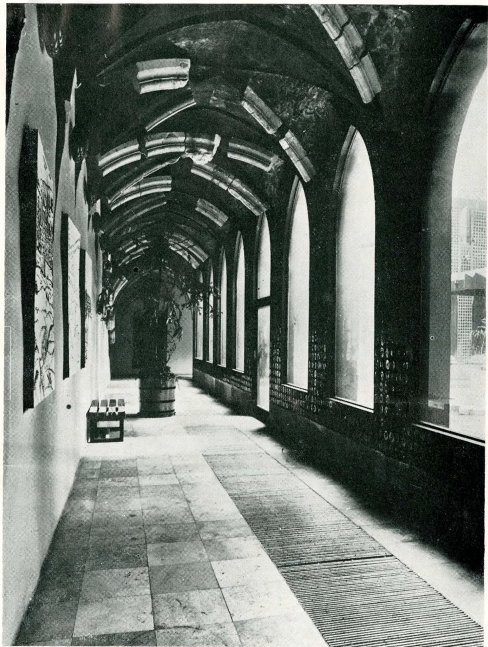
20. A kerengő déli folyósója, boltozatrendszerét rézlemez mezők és felakasztott eredeti bordák jelzik
