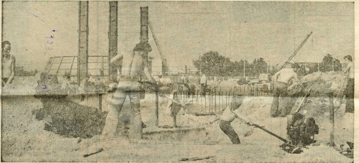
Az alapozási munkák 1978. március 1-én kezdődtek. A húszezer társadalmi munkás az építés során több mint százezer társadalmi munkárárt teljesített
