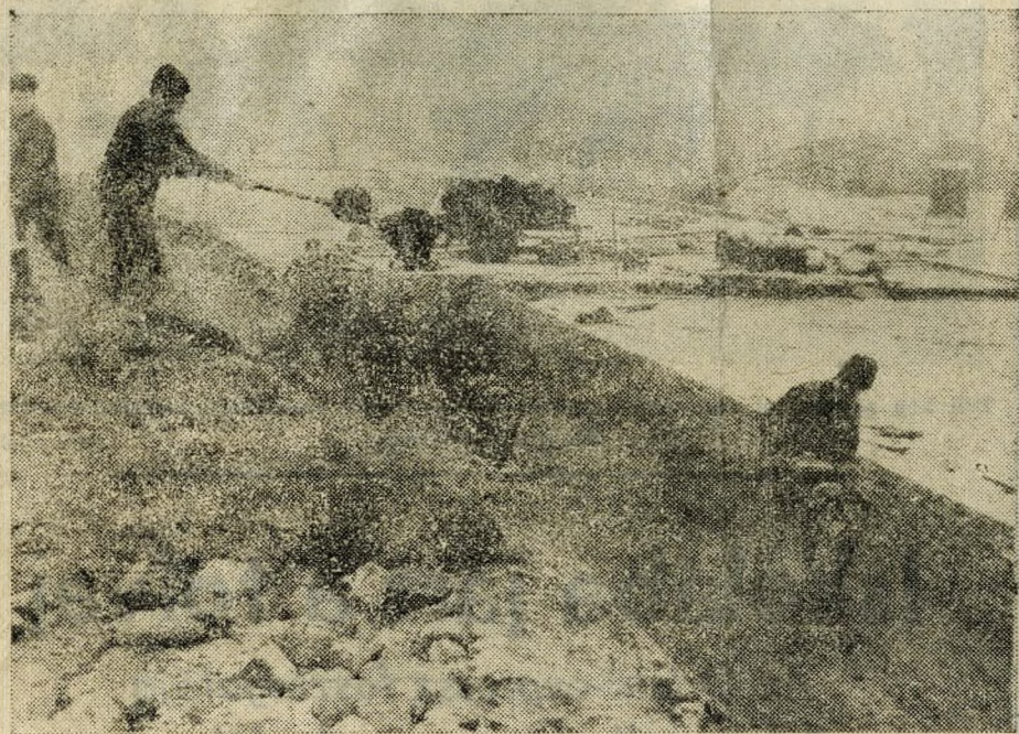
Gyors ütemben épül az Eörs vezér téri aluljáró
