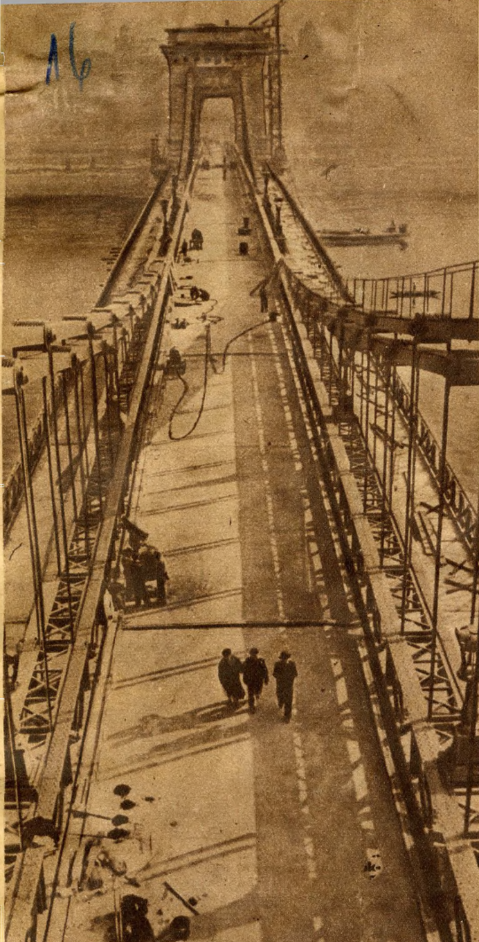
Még néhány hét és emberek, járművek ezrei mennek majd át az új Lánchídon. 1945-ben indultak első rohamra Gerő Ernő vezetésével a hős magyar hidépítők és ma már a Lánchíd is áll a két part között. Képünk már a híd aszfaltozási munkáiról készült
