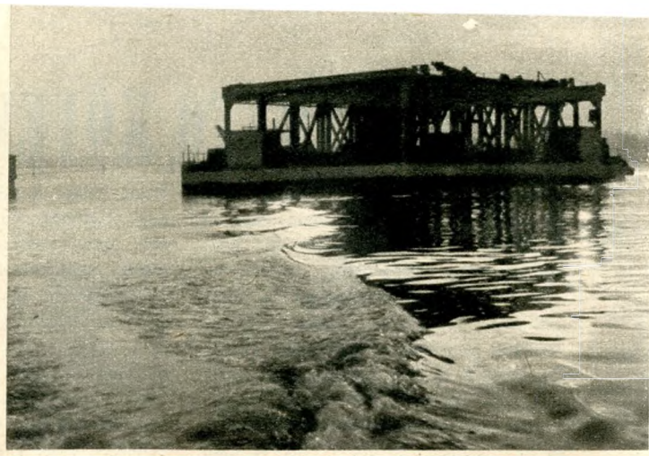
A Palotai-szigeti kísérleti vízkivételi mű szivótorkának súlykút
