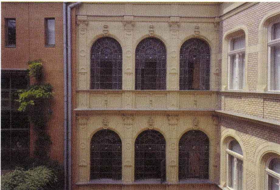
A Baross utcai szárny és a Reviczky utcai kisebbik palotaépület találkozásából kialakított belső udvari front
