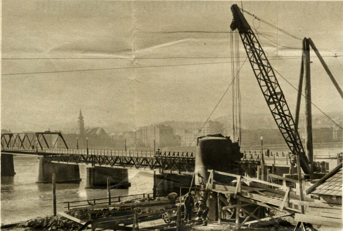
Stavba budapeštské podzemní dráhy na úseku Rákócziho ulice již značně pokročila.
