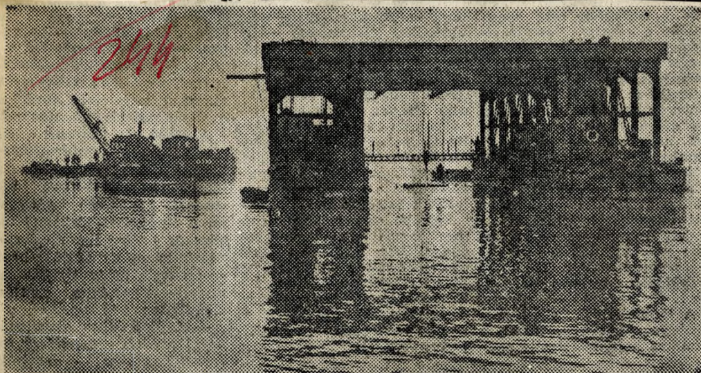
INDUL A SZIFONFEJ A DUNA ALÁ. A »Nemzeti« úszómű segítségével süllyesztik a Duna fenekére a felszíni vízkivételi mű 23 tonnás vasbeton szifonfejét
