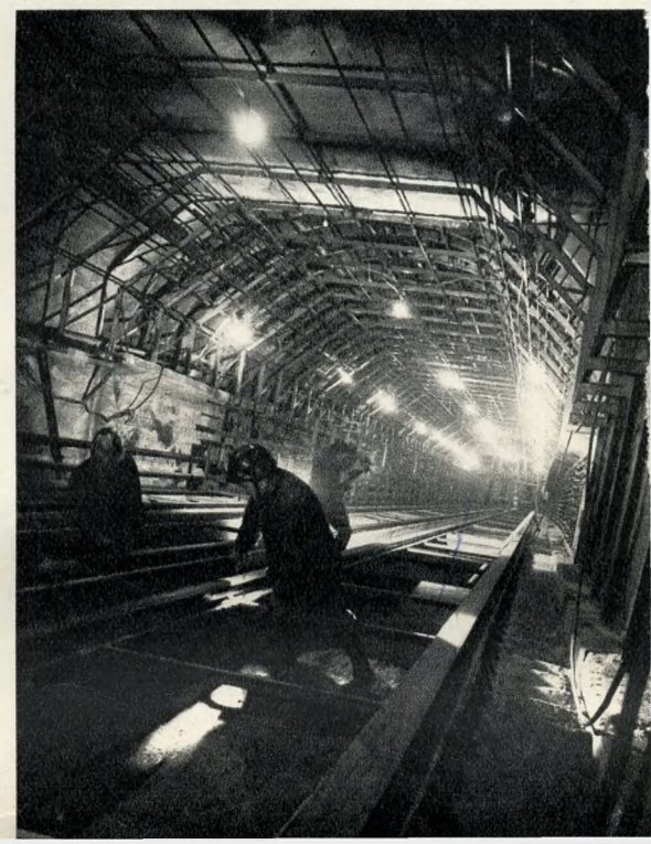
Az aluljárót fűtő csőhálózat a Vérmezőnél
