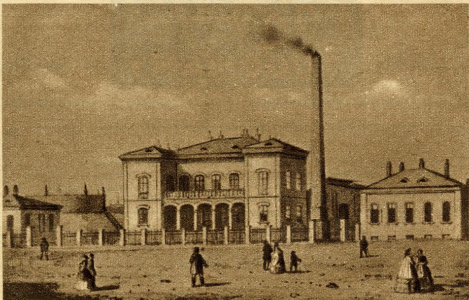
A Lóvásár téren (ma : Köztársaság tér) 1856-ban épült gázzár. Ez volt Budapest első gázzára
