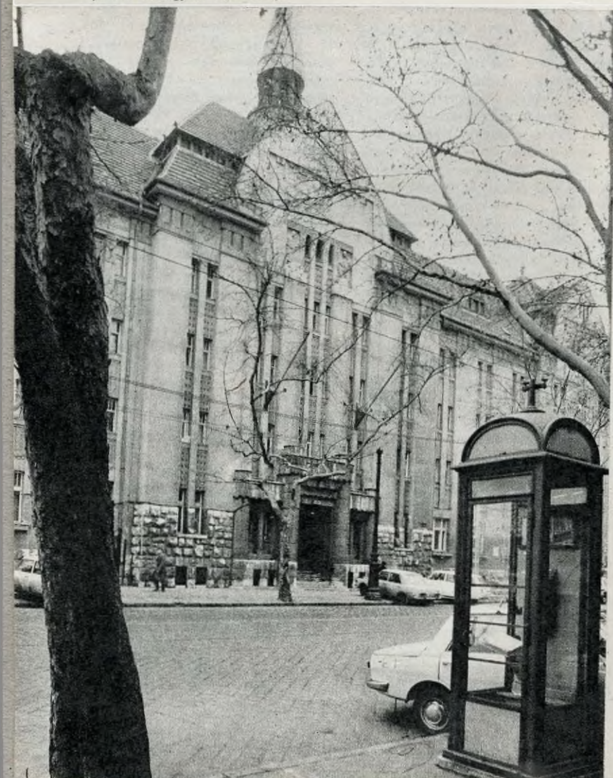
A volt Népszálló — ma Dózsa György Otthon — homlokzata (Dózsa György út 150—152.)
