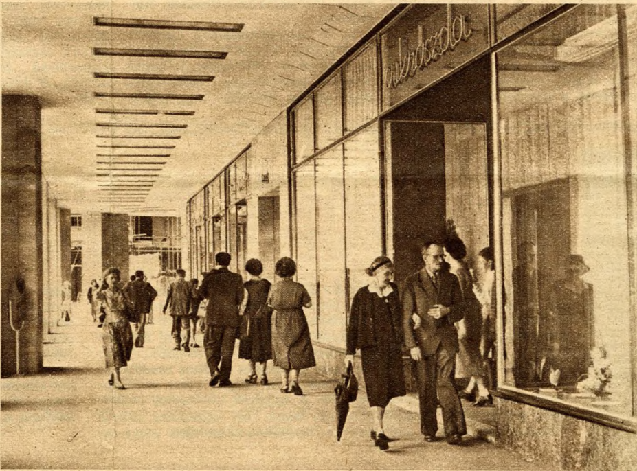
AZ ARKÁDOK TÖMÖR OSZLOPAI éppolyan biztossággal hordják a házak súlyát, mint a falak horáták az dtépités előtt. Az oszlopokat egyöntetű, esiszott kőlapokkal borítják be. Es miközben a házakon kőművesek dolgoznak, egy pillanatra sem áll meg az út forgalma. Az épülő arkádok mellett elhaladó gyalogjárókat alagútszerű átjárók óvják a portól és a törmelékettől. Jobbra: az egyik, már befejezett arkád, világos, barátságos — este pedig a mennyezetén elhelyezett sűrű neonszűvek fényétől megvilágítva — csodálatos képet mutat. Az üzletek az arkádok alatt a legmodernebb formákban épülnek
