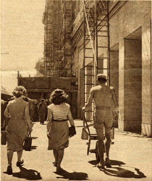
AZ ARKÁDOK TÖMÖR OSZLOPAI éppolyan biztossággal hordják a házak súlyát, mint a falak horáták az dtépités előtt. Az oszlopokat egyöntetű, esiszott kőlapokkal borítják be. Es miközben a házakon kőművesek dolgoznak, egy pillanatra sem áll meg az út forgalma. Az épülő arkádok mellett elhaladó gyalogjárókat alagútszerű átjárók óvják a portól és a törmelékettől. Jobbra: az egyik, már befejezett arkád, világos, barátságos — este pedig a mennyezetén elhelyezett sűrű neonszűvek fényétől megvilágítva — csodálatos képet mutat. Az üzletek az arkádok alatt a legmodernebb formákban épülnek
