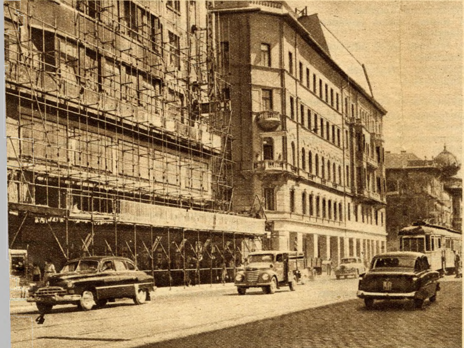
AZ ARKÁDOK TÖMÖR OSZLOPAI éppolyan biztossággal hordják a házak súlyát, mint a falak horáták az dtépités előtt. Az oszlopokat egyöntetű, esiszott kőlapokkal borítják be. Es miközben a házakon kőművesek dolgoznak, egy pillanatra sem áll meg az út forgalma. Az épülő arkádok mellett elhaladó gyalogjárókat alagútszerű átjárók óvják a portól és a törmelékettől. Jobbra: az egyik, már befejezett arkád, világos, barátságos — este pedig a mennyezetén elhelyezett sűrű neonszűvek fényétől megvilágítva — csodálatos képet mutat. Az üzletek az arkádok alatt a legmodernebb formákban épülnek
