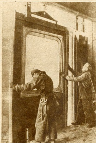
Helyére illesztik a paneles típusú függönyfal egy elemét
