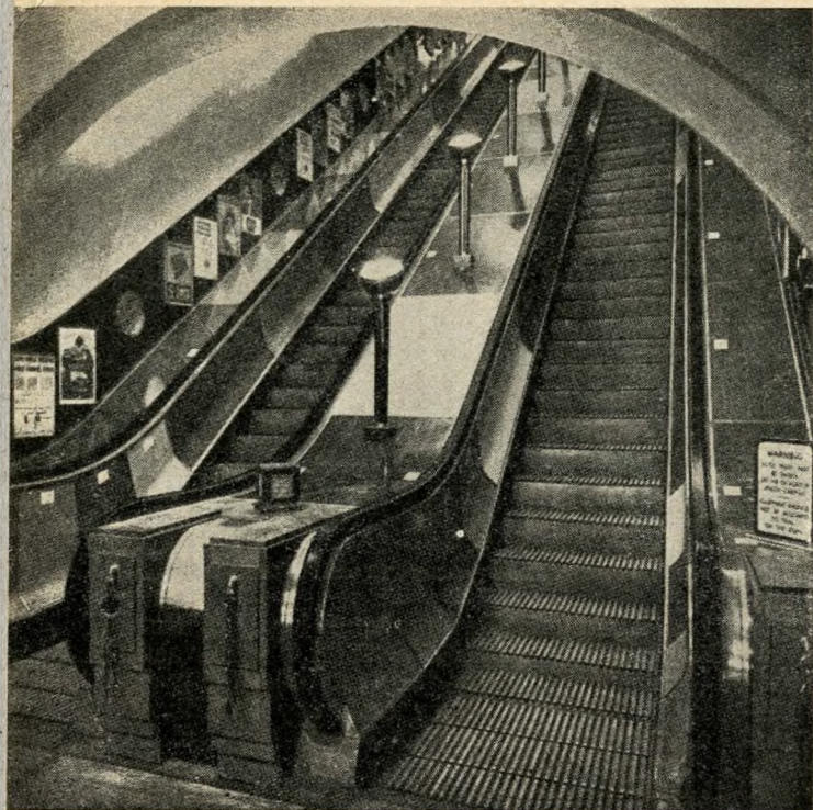
Ötemelet mélyen levő földalatti vasút mozgólépcsője. A közepén elhelyezett elektromos szem figyeli, hogy mikor jön utas és megindítja a mozgólépcsőt
