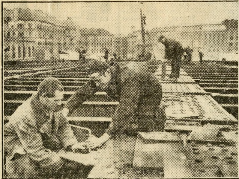
Nagy László elvtárs, a szerelőbrigád vezetője Nagy Sándor elvtárral, a brigád egyik tagjával esomólemezt készít elő szereléshez.
