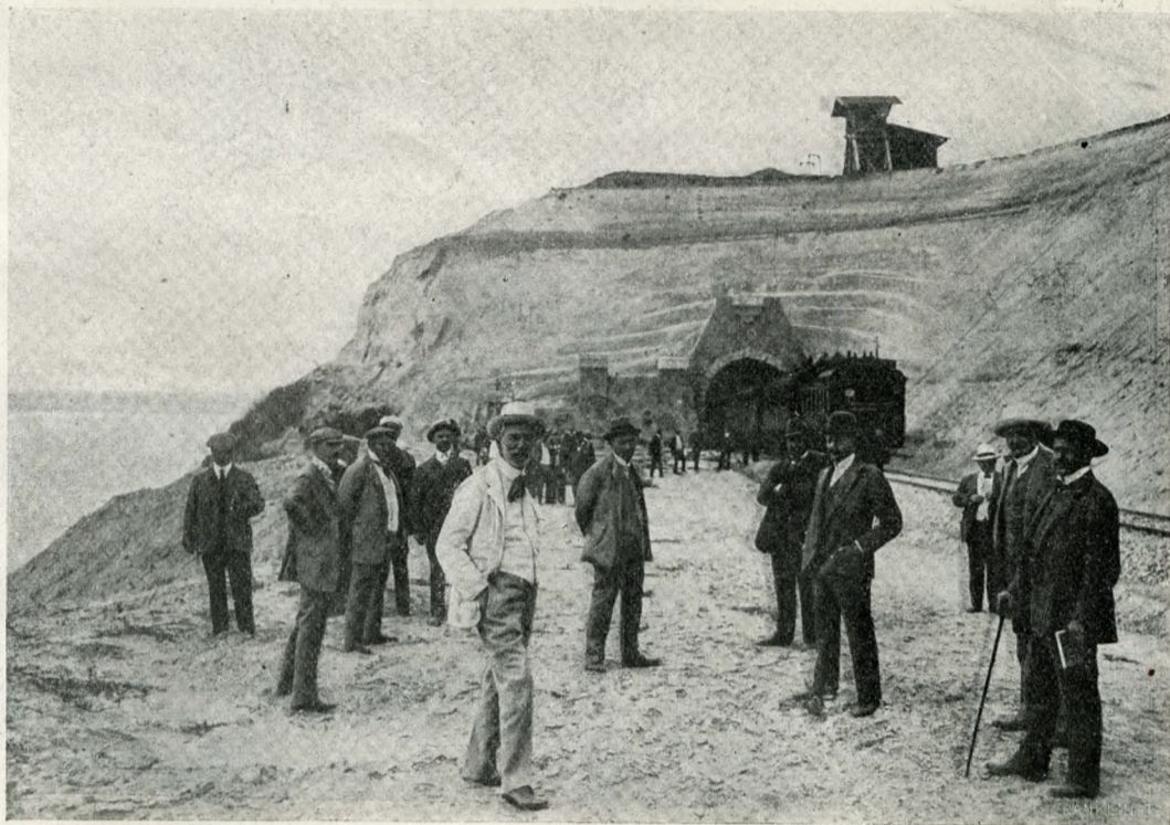
AZ ÚJ BALATONI VASÚT AKARATYAI ALAGÚTJA ÉSZAK FELŐL.
