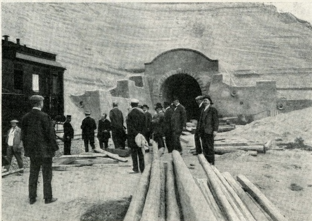
AZ AKARATTYAI ALAGÚT A BALATON FELŐL.
