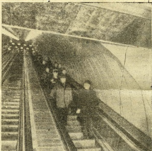
A mozgólépcső nagy sebességgel halad, 92 cm-t egy másodperc alatt.
