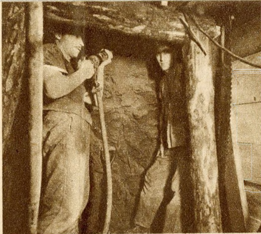
A pesti Duna-part alatti — azóta elkészült — pajzskamrát 1951-ben kezdték építeni. Képlünk még abból az időből ered, és jól láthatjuk rajta a szilárd agyagot
