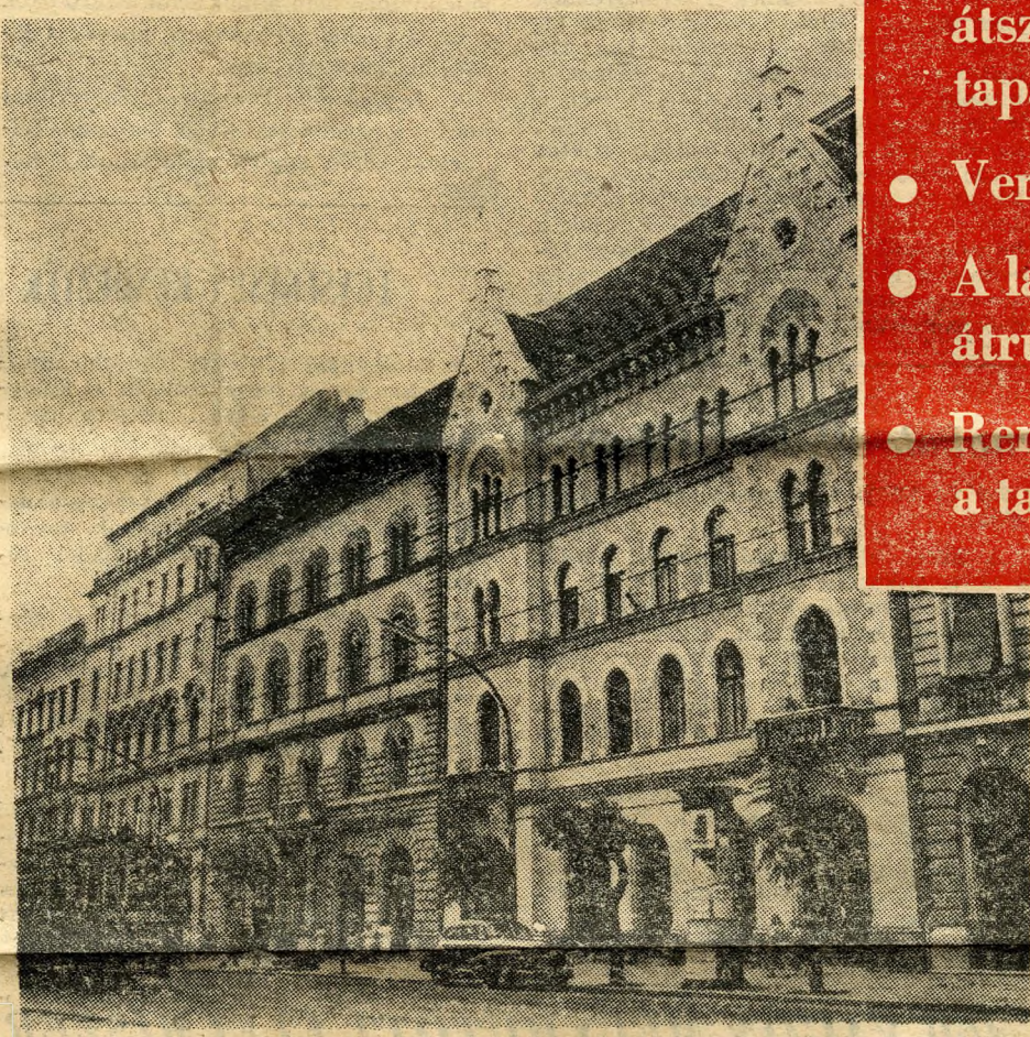
Megszépülve bontakoznak ki az állványerdőből a Körút megfiatalított házai
