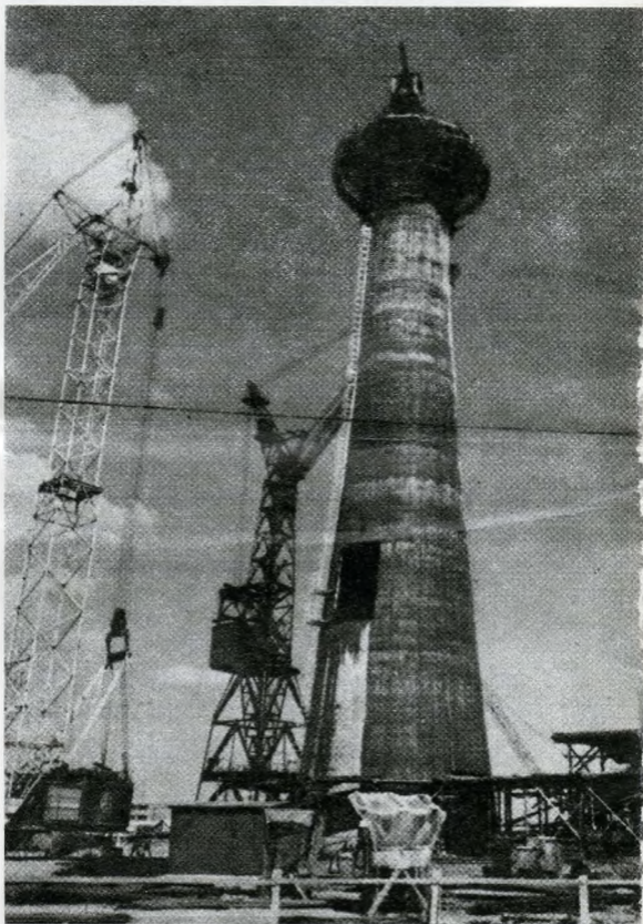
Az épülő szemétegetőmű kéménye
