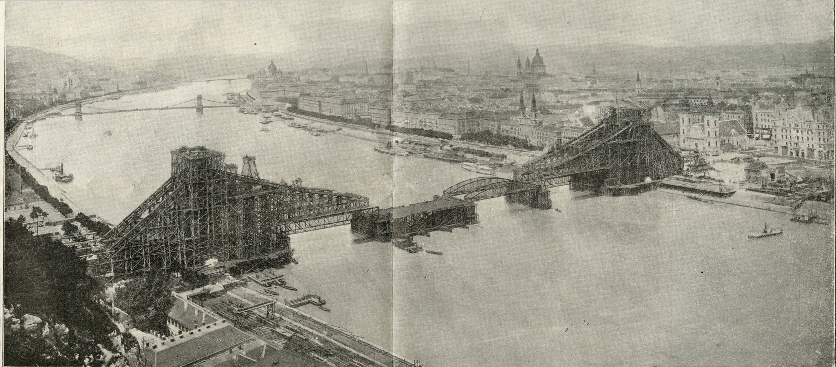
AZ ESKÜTÉRI HID ÉPÍTÉSE. — A HID A GELLÉRTHEGYRŐL NÉZVE.
